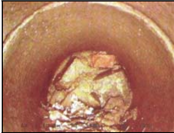
Photographie 3.11: Exemple d'effondrement total (extrait du glossaire AGHTM, édition 1998)
