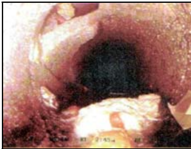
Photographie 3.10: Exemple d'un effondrement partiel (extrait du glossaire AGHTM, édition 1998)
