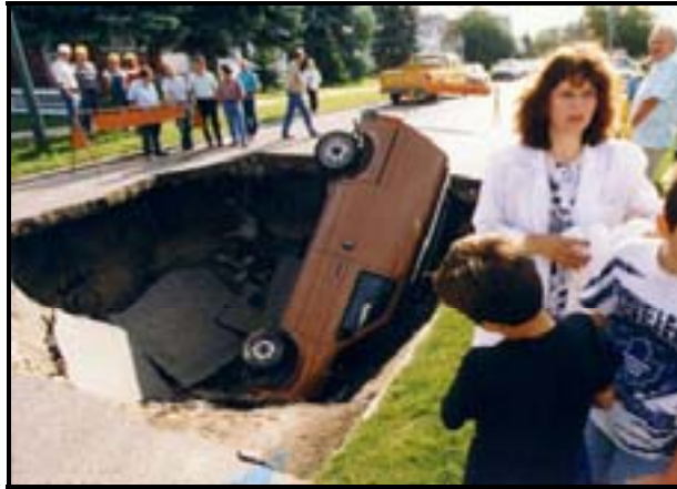
Photographie 2.2: Effondrement d'une conduite sous chaussée Winnipeg, en 1990 (Macey, 2002)
