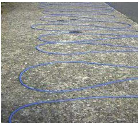
Fig. 18 Déploiement câble en accordéon
