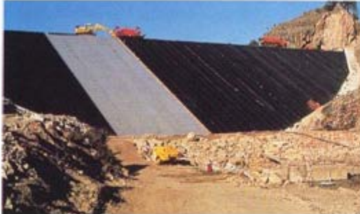
Mise en œuvre d'une géomembrane sur le masque d'un barrage (ISTED, 1987)...
