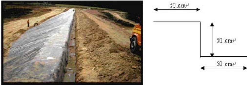
fig. 4.7 Tranchées d'ancrage.+
