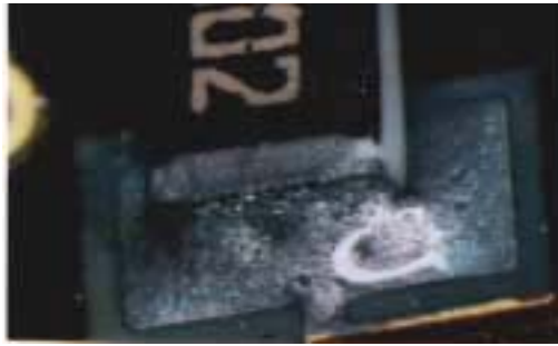
Figure 34 : Dégradation des brasures des condensateurs
