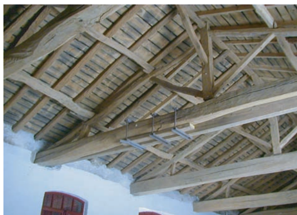
FIG. 1 – Renforcement d'un entrain de ferme
