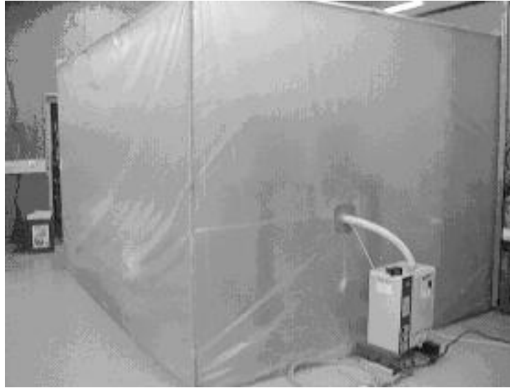
FIG. 2.3 – Enceinte de stabilisation des bois
