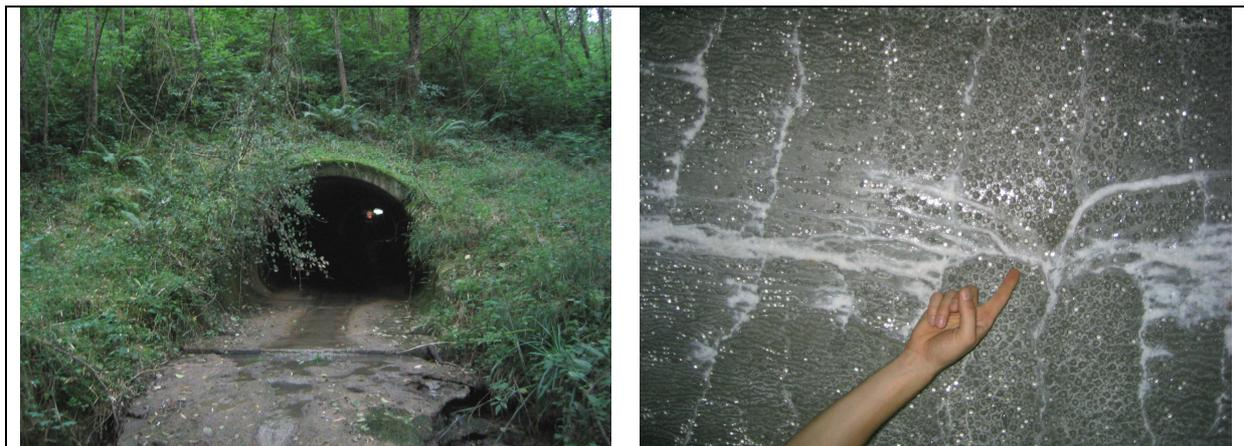
**Figure 6. 29** Photographie de l'entrée Nord-Ouest du conduit (à gauche) et de la surface de l'ouvrage présentant de nombreuses fissures remplies de calcite (à droite)
