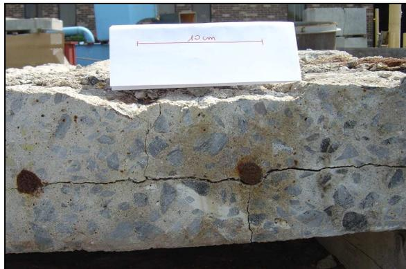
**Figure 8.1 Photographie d'une délamination due à la corrosion de l'armature**
