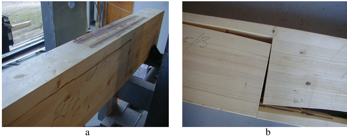
Fig. 90 : Fissuration du bois pour des plats collés
