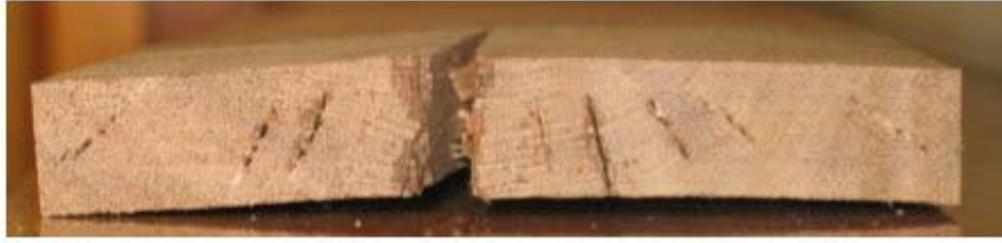
Figures IV. 21 : Fentes superficielles et internes près de bout fissuré gravement.
