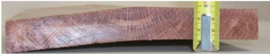
Figure IV. 20 : Tuilage et gauchissement remarqués sur quelques planches séchées.
