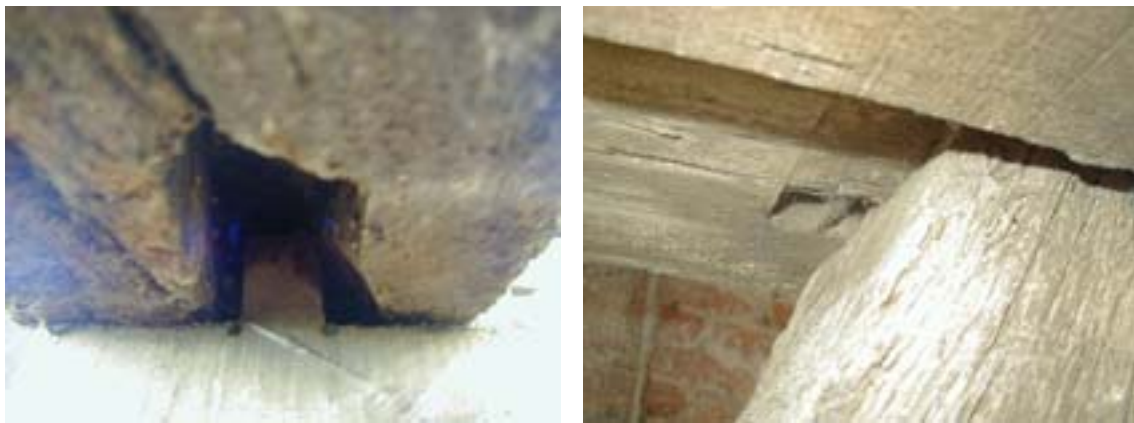
figure 15 : Vues de deux assemblages tenon-mortaise.
