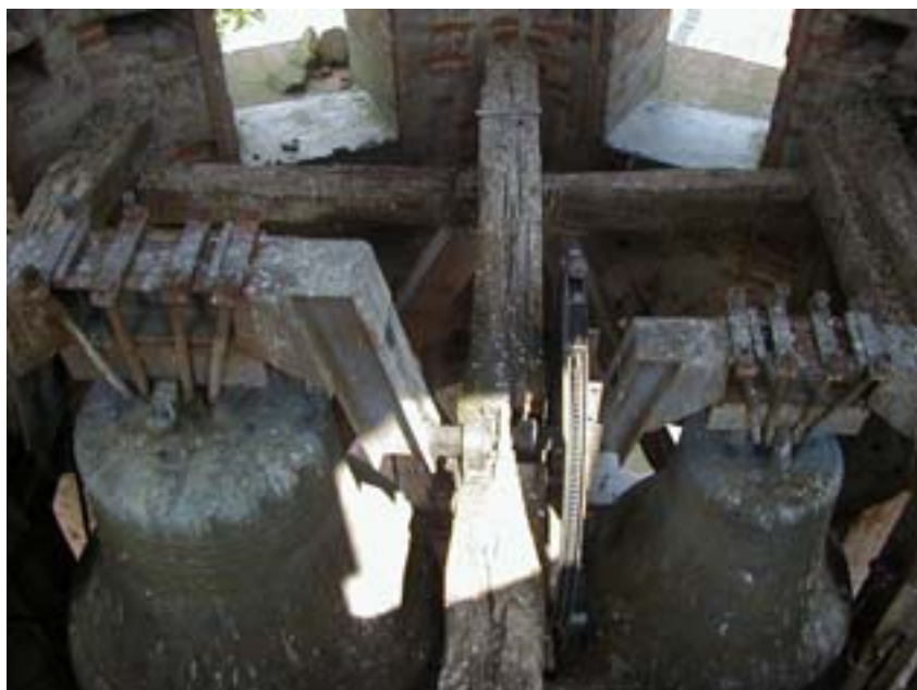
figure 11 : Vue de dessus de la structure bois supportant les deux cloches.
