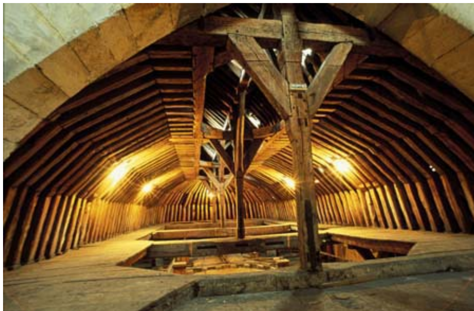
figure 4 : Vue de la charpente de la Cathédrale de Versailles.
