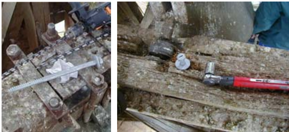
figure 34 : Suppression des jeux d'assemblages par la mise en place de tire-fonds.
