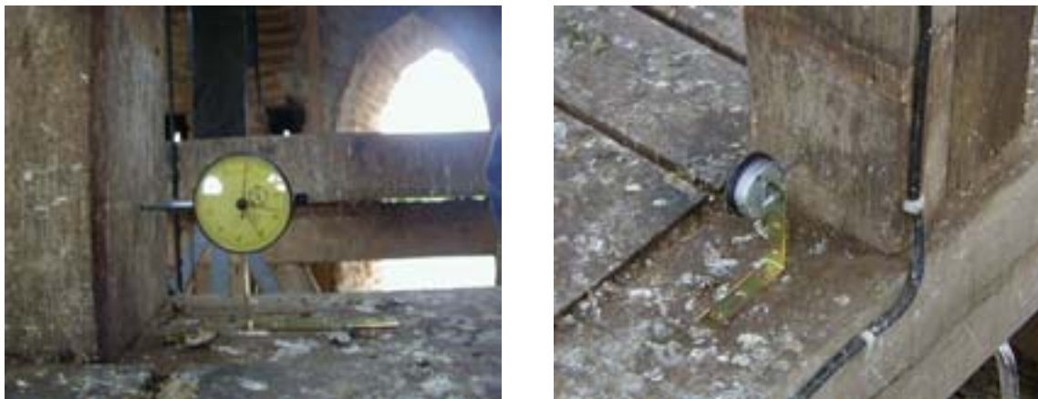
figure 30 : Mesure des jeux d'assemblages critiques in situ.
