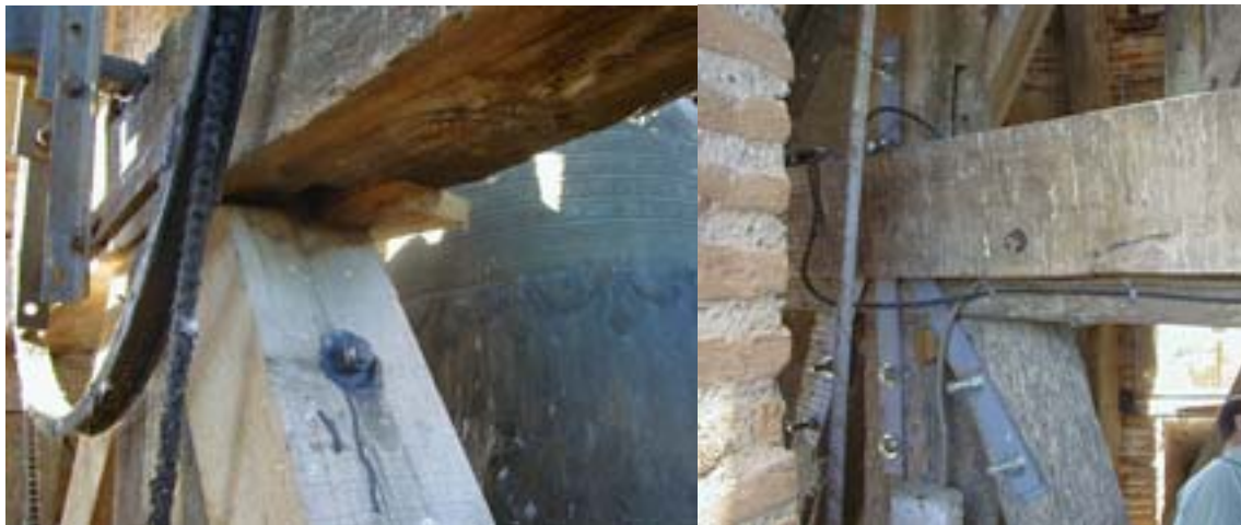
figure 13 : Renforcement d'un assemblage avec une tige filetée et avec des plaques boulonnées.
