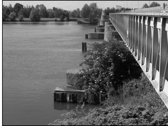
Figure II-41 : Barrage de Poses, estuaire de Seine.
